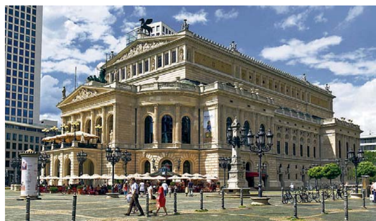
In der Alten Oper in Frankfurt am Main finden zahlreiche Konzerte und Kongresse statt. FOTO: KASPER-AUFZÜGE
