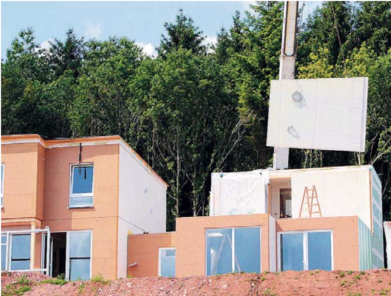
Noch ist der künftige Ferienpark am Bostalsee eine Baustelle. Aber im Sommer nächsten Jahres sollen hier Besucher Urlaub machen. Bis dahin braucht Center-Parcs mehr als 200 Beschäftigte, um den Parkbetrieb aufrecht zu erhalten. FOTOS: BONENBERGER & KLOS
