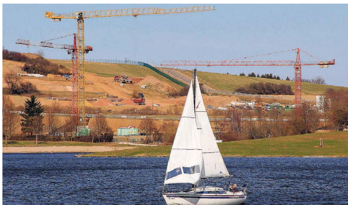
Die Baustelle des Ferienparks vom Bostalsee aus gesehen. FOTO: B&K
