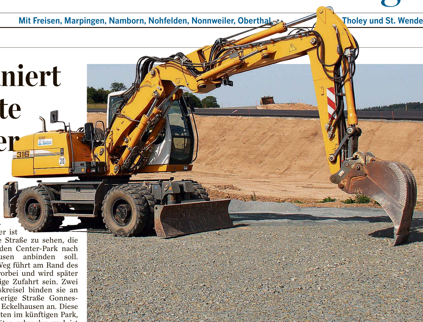
Erste Flächen hat der Bagger schon platt gemacht, damit hier bald Ferienhäuser am Bostalsee aufgebaut werden können. FOTOS: MAI
